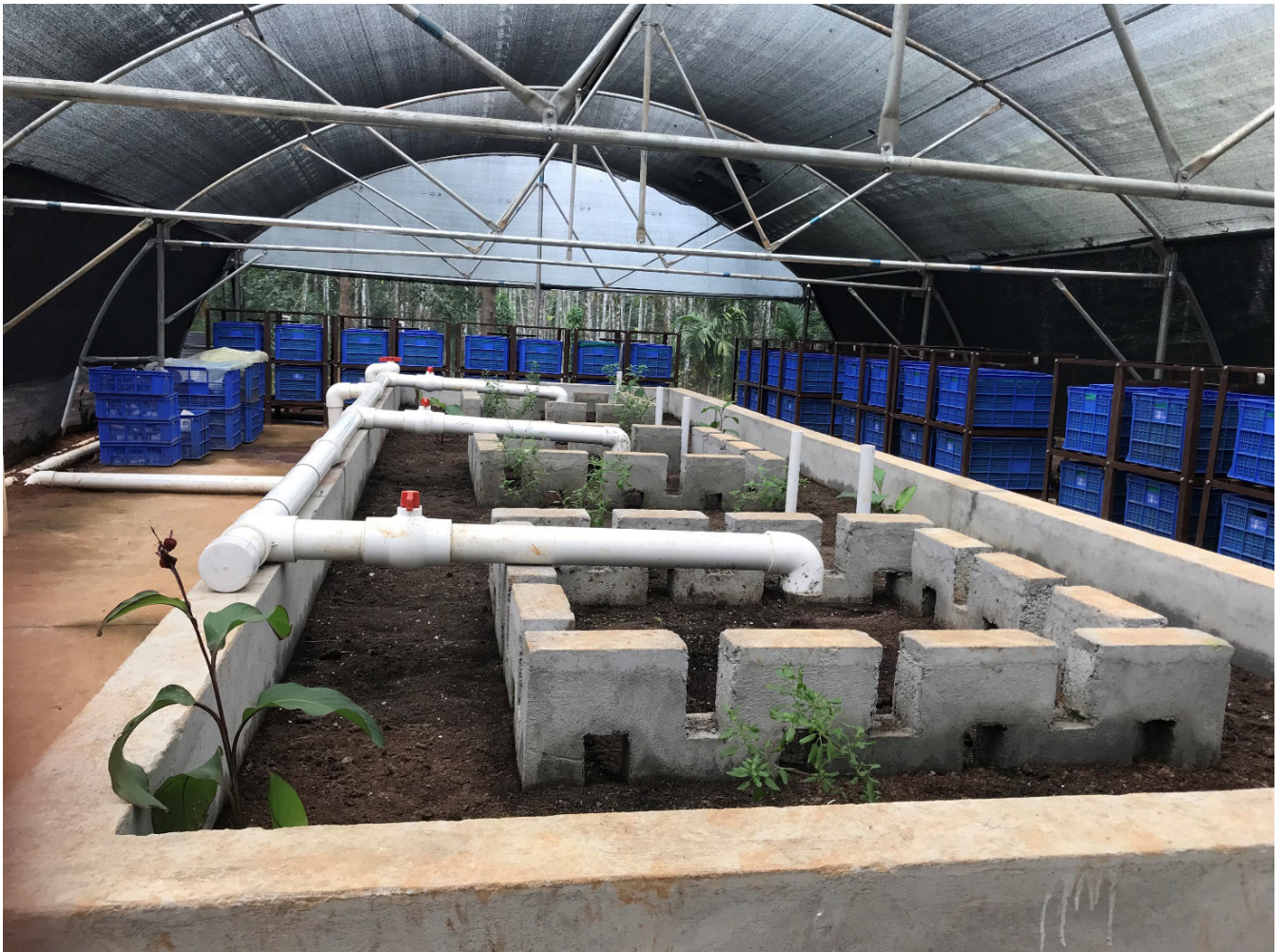
Tiger biofilter bed at the Kalpetta FSTP
