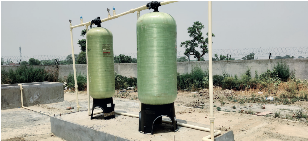
हाथरस में उन्नत उपचार के लिए दबावयुक्त रेत और सक्रिय कार्बन फिल्टर
