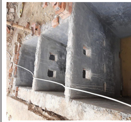
चित्र 1: चुनार में निर्माणाधीन सेप्टिक टैंक
