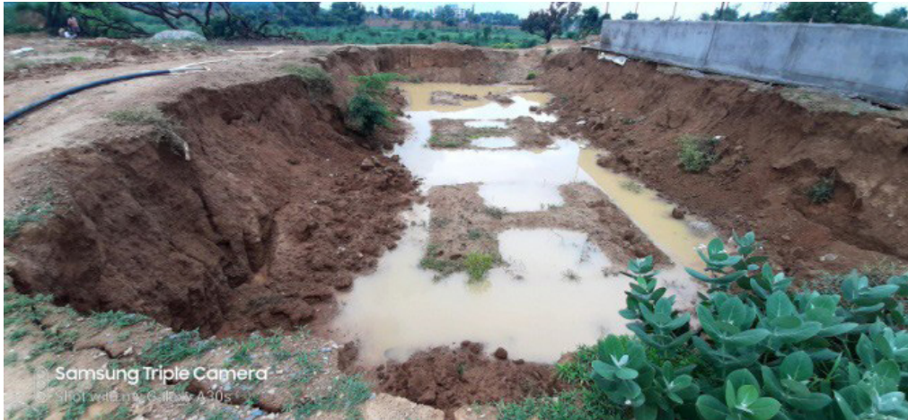
चित्र 9: प्लॉटेड ड्राइंग बेड का निर्माण वर्षा के कारण बाधित रहा
