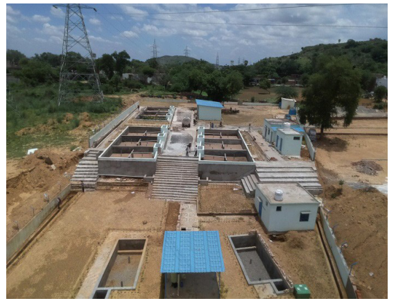
चित्र 18: चुनार में एफएसटीपी का निर्माण कार्य प्रगति पर
