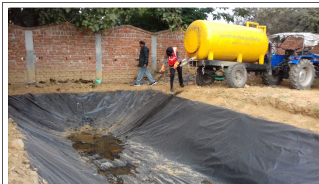
चित्र 7: फीकल-स्लज के सुरक्षित निपटान के लिए अंतरिम समाधान के रूप में चुनार में ट्रेचिंग
