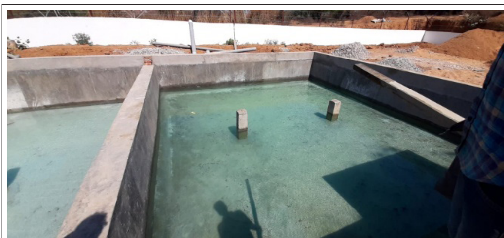
चित्र 13: यह सुनिश्चित करने के लिए कि संरचना रिसाव-रोधी थी, हाइड्रोलिक टेस्ट किए गए
