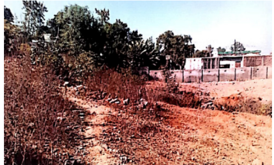
तस्वीर 2: एफएसटीपी साइट (6+12केएलडी)
